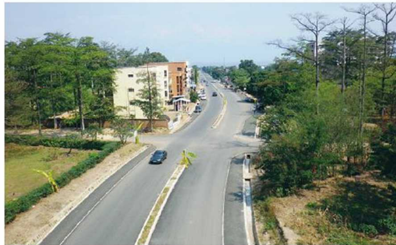
ワールド開発工業は、アフリカのブルンジの首都ブジュンブラ市で既設道路の改良工事に取り組んでいる。日本の政府開発援助(ODA)の対象工事で、元請けとして受注した。工期は11年3月～13年3月 (写真:ワールド開発工業)
